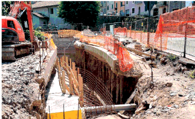
Lo scavo Lavori in corso in piazza della Repubblica per la realizzazione di una canale che raccolga l'acqua proveniente dalla montagna
