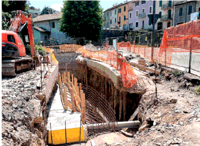
Lo scavo Lavori in corso in piazza del Repubblica per la realizzazione di una canale che raccoglie l'acqua proveniente dalla montagna
